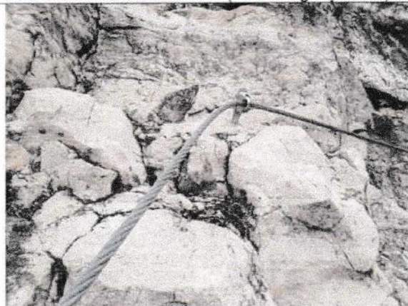
F05- Mászóutak kialakítása (közethorgonyzások)
