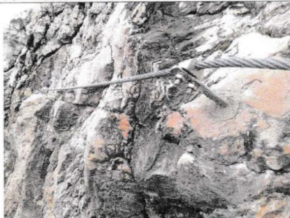
F03- Mászóutak kialakítása (közethorgonyzások)
